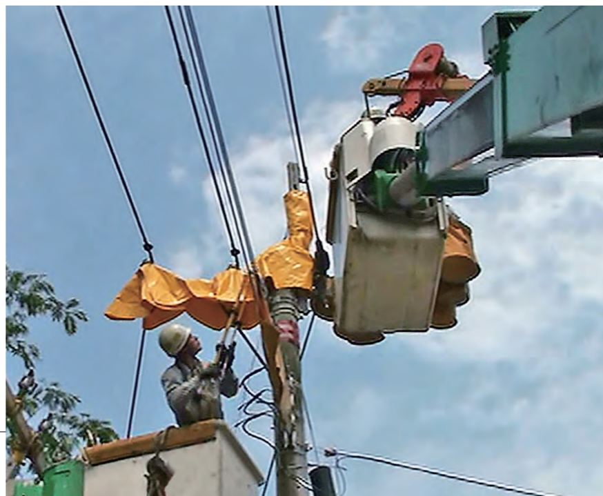
▼電柱上での間接活線作業
