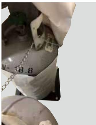
20kg容器用の場合は固定用鎖をプロテクター開口部に通して「マイテバリア」の側面を通過させてください。
