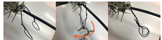
※バンド打ち器・バンド線を使用した固定例です。余長はニッパ等で切断して下さい。
