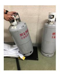
専用置き台の上に充填容器を置きます。
