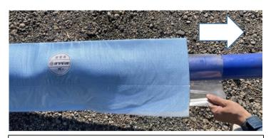
製品を広げ、PE管に通します。 スリーブの端部を持って作業すると、取付が容易です。
